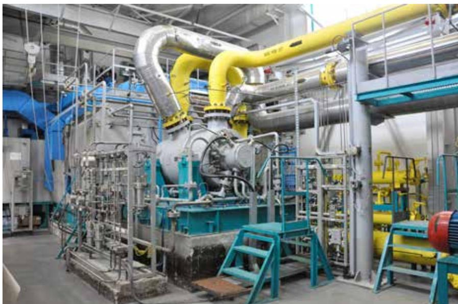
**Фото 2. Компрессорный агрегат 4ГЦ2-124/14-79 ГТУ для Южно-Балыкского ГПК, «СибурТюменьГаз» (комплексный поставщик - «Казанькомпрессормаш», Группа ГМС)**
