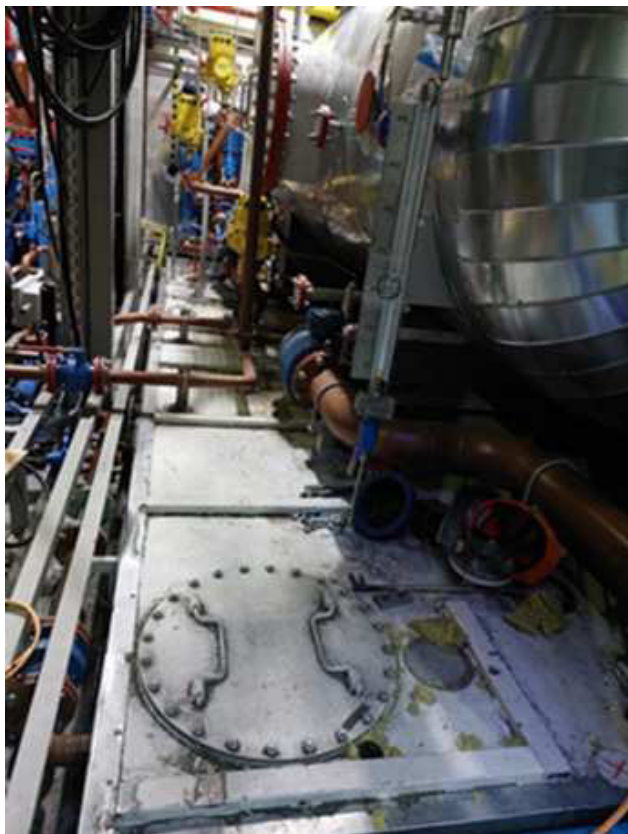
Рисунок 10. Дренажная емкость МКУ-1000 ТАКАТ 120.2-7 М4а ХЛ1
