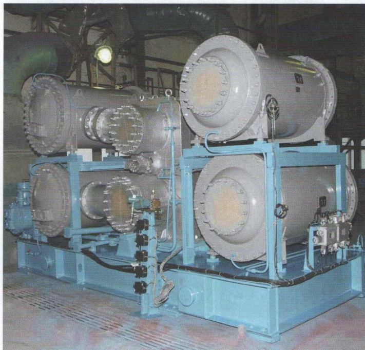
Центробежная компрессорная установка АЭРОКОМ АА-250/16 с приводом от электродвигателя мощностью 2000 кВт для работы в составе системы термостатирования стартового ракетного комплекса
