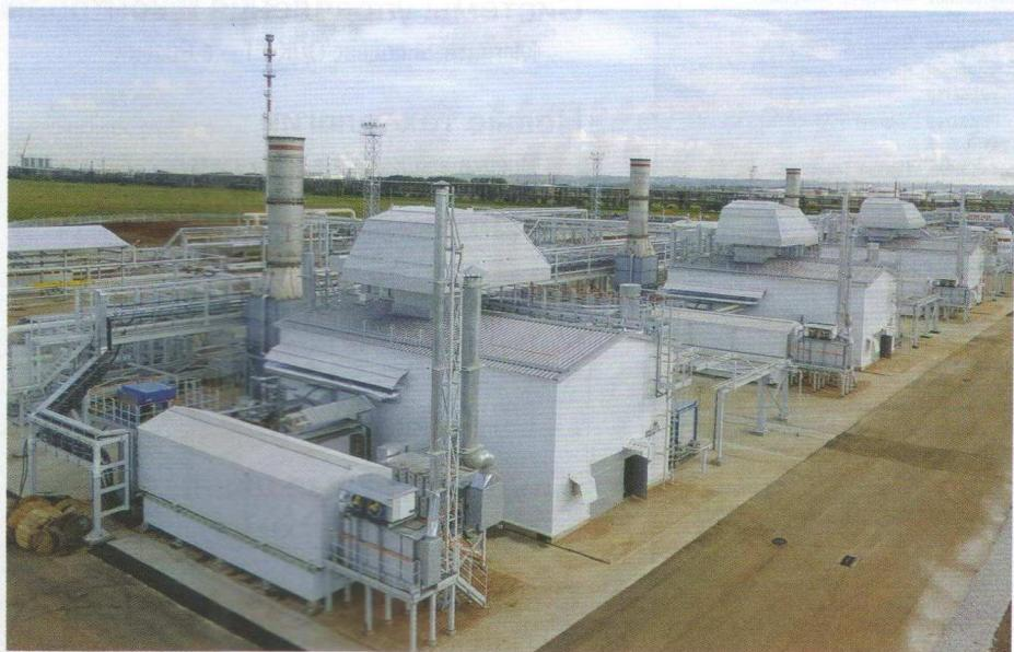
Фото 1. Дожимная компрессорная станция «ЛУКОЙЛ-ПНГП» в составе трех турбоприводных агрегатов 4ГЦ2-70/17-62 ГТУ
